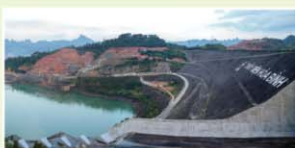
Tổng công ty thi công Dự án Nhà máy Thủy điện Hòa Bình mở rộng.
